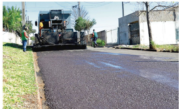
Detalhe da revitalização de uma das vias de Cambé
