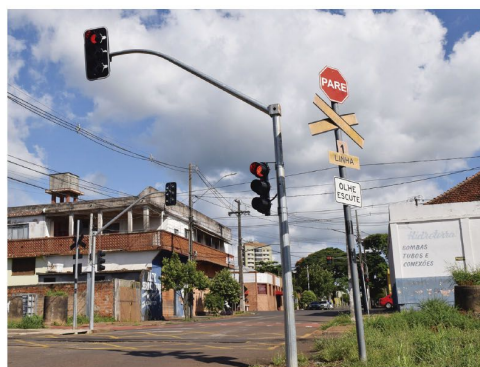
PN Sensoriada 'fecha' o sinal quando o trem está a 400 metros de distância e só abre depois que todo o comboio tiver passado
