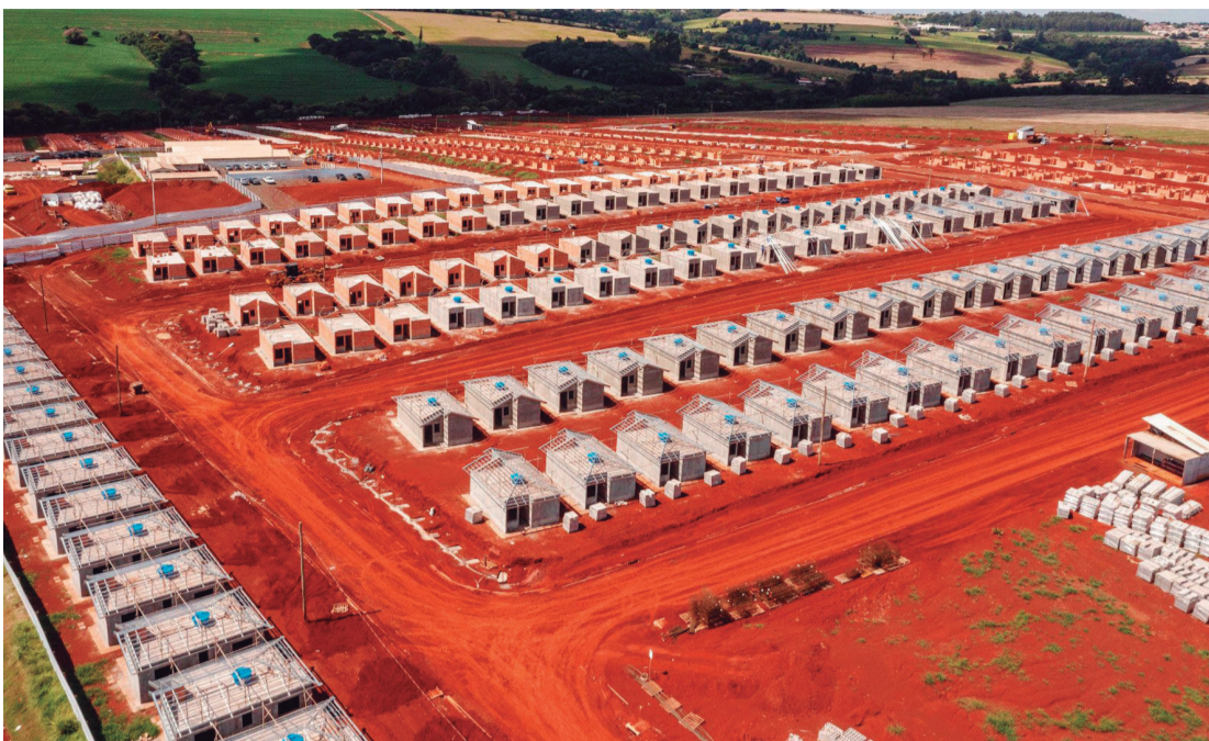
O Residencial Bem Viver Arapongas 2 está com as obras aceleradas
