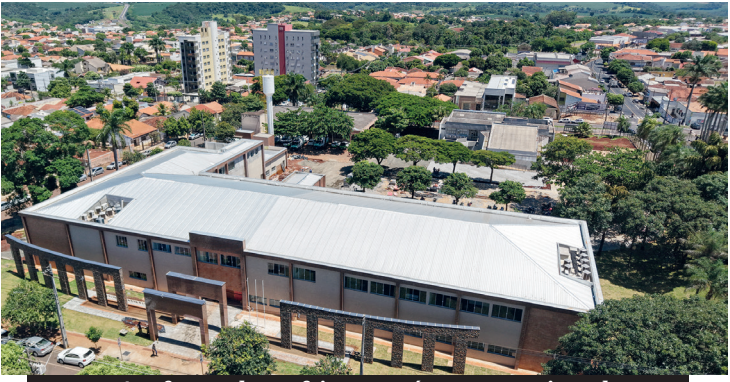
A reforma da prefeitura está quase terminando
